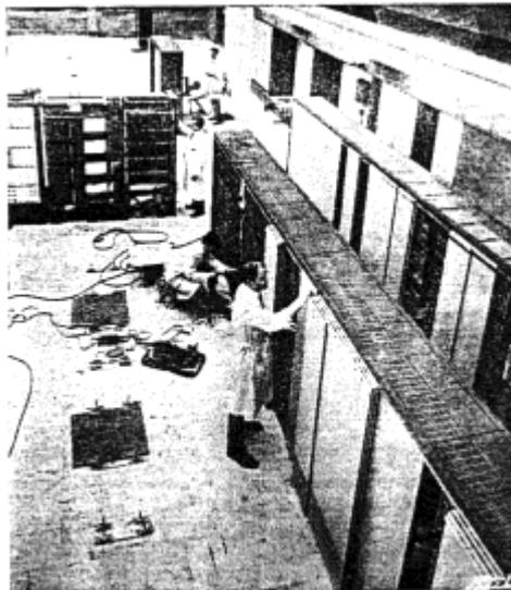
Fig. 35. — Un ensemble GAMMA 60 en cours d'installation.
